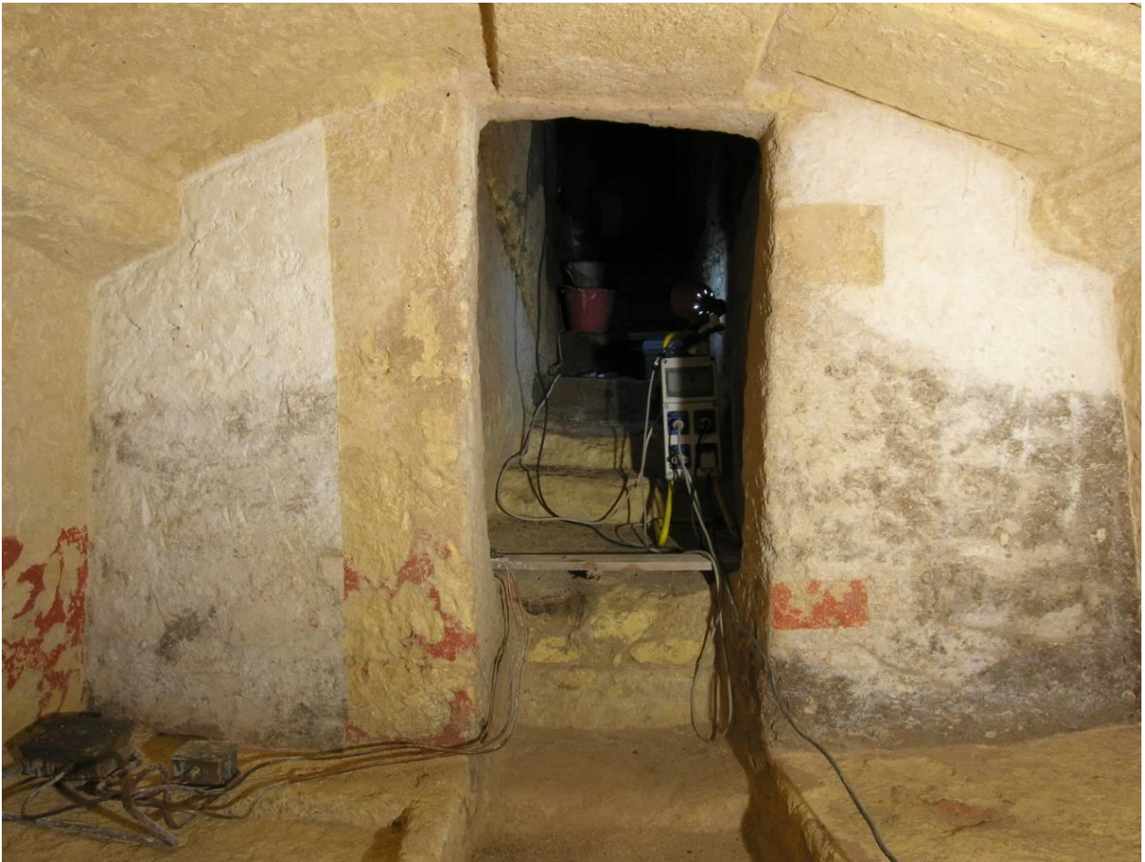
5. Parete d'ingresso - lato interno, durante il restauro.
