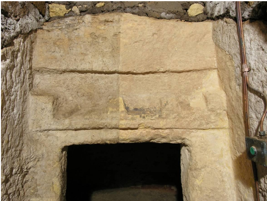
9. Architrave, durante il restauro.
