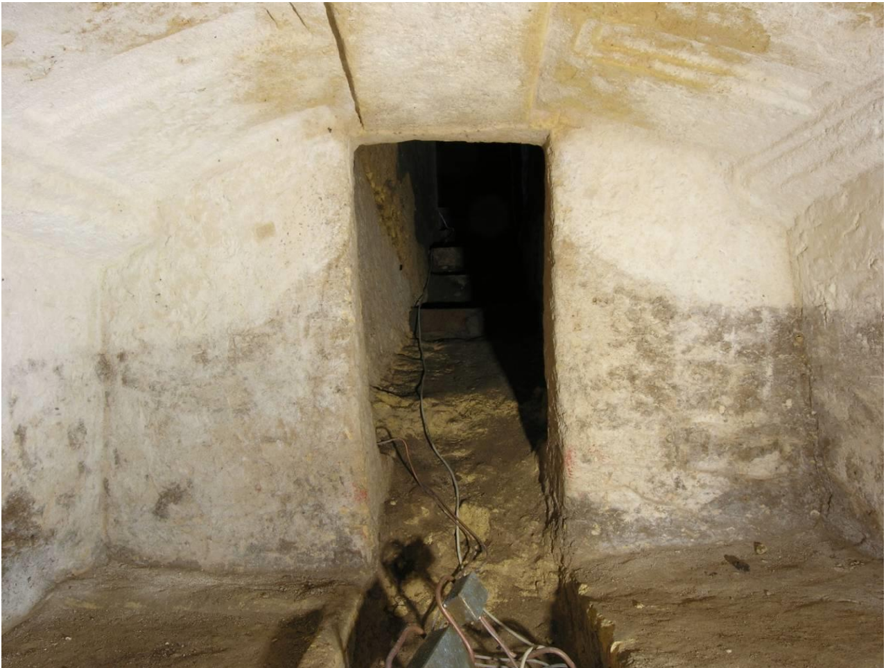
1. Parete d'ingresso prima del restauro
