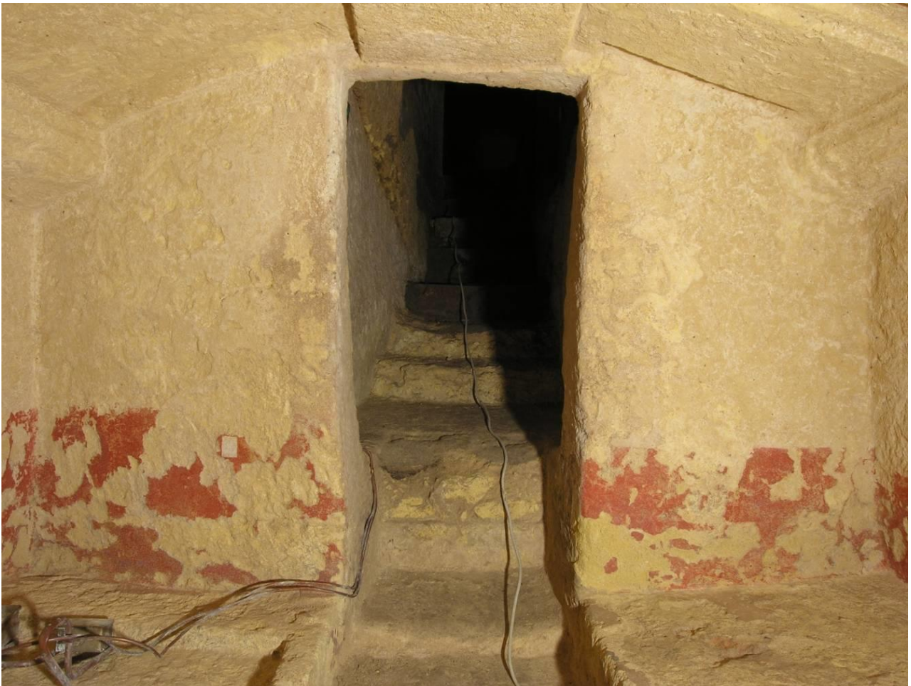
6. Parete d'ingresso – lato interno, dopo il restauro.
