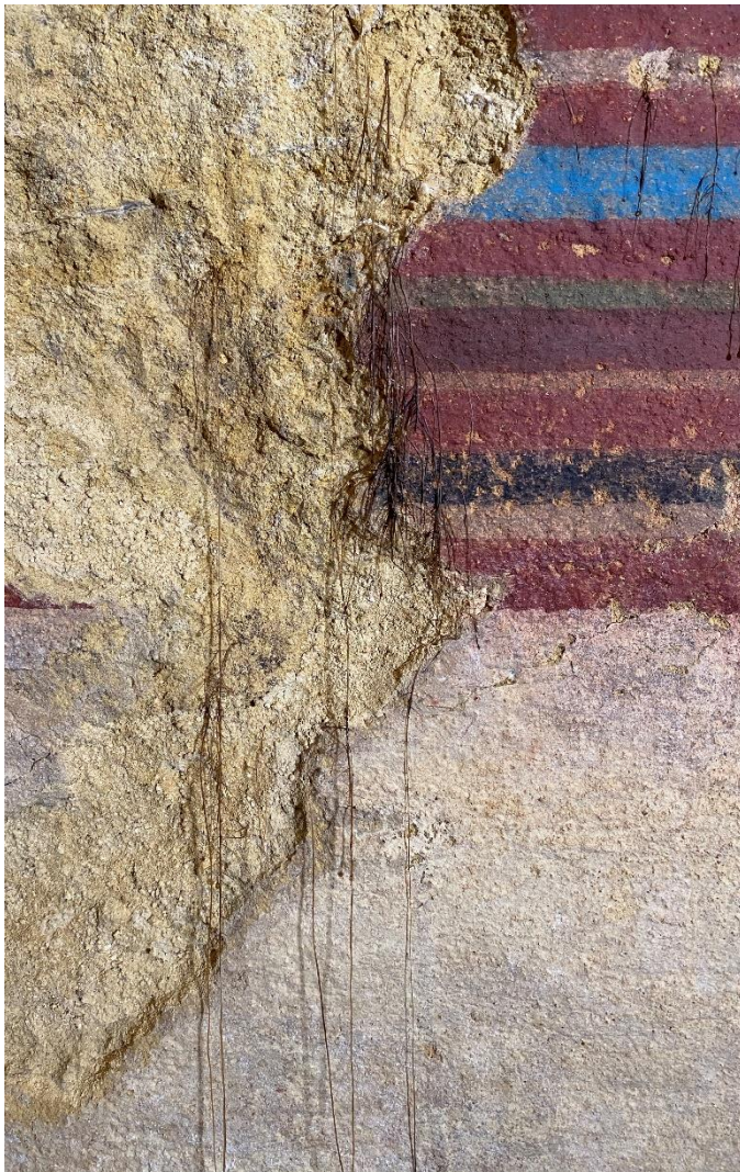
La superficie della parete destra invasa dagli apparati radicali capillizi di piante di finocchio selvatico
