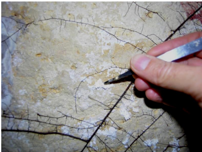
Fig. 8 rimozione delle radici dopo il consolidamento
