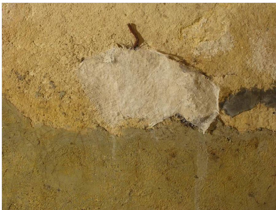
Figure 11, 12, 13 e 14 il frammento della parete sinistra durante le operazioni di consolidamento e rimozione delle radici
