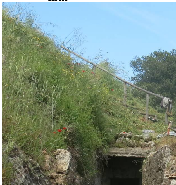
Figura 8 - La stessa area dopo il taglio degli alberi
