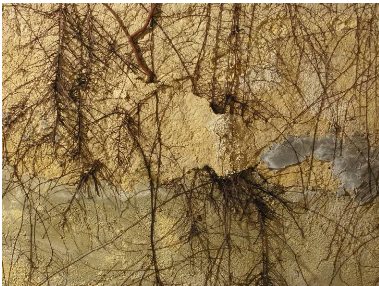
Figura 9 - particolare della parte sinistra – le radici fanno sollevare e cadere la superficie.
