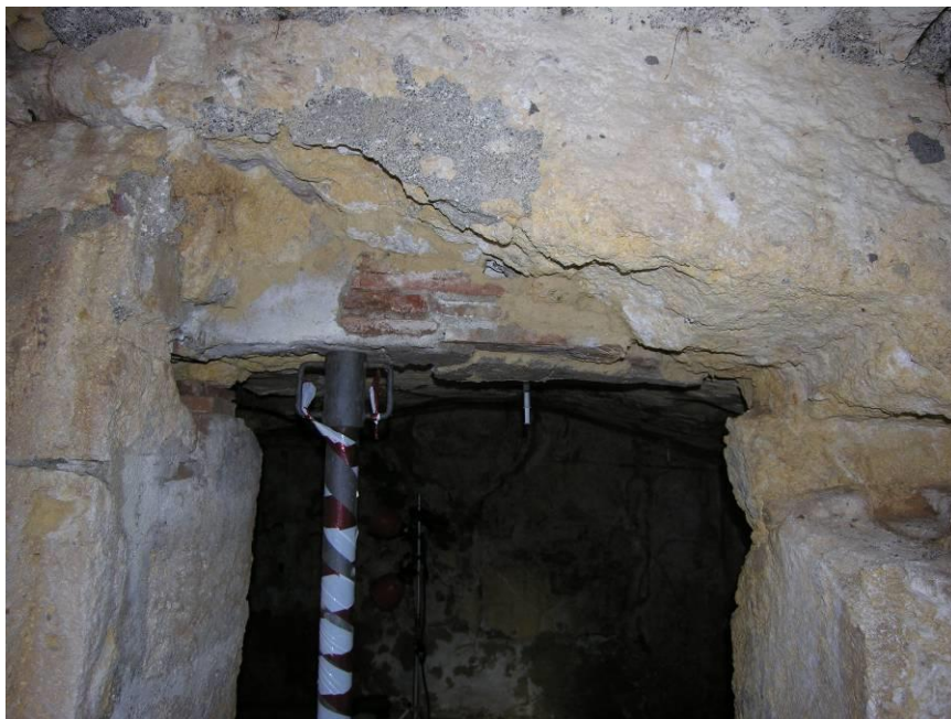
Figg. 13, 14 e 15 - Ripristino dell'architrave dell'ingresso e degli stipiti.
